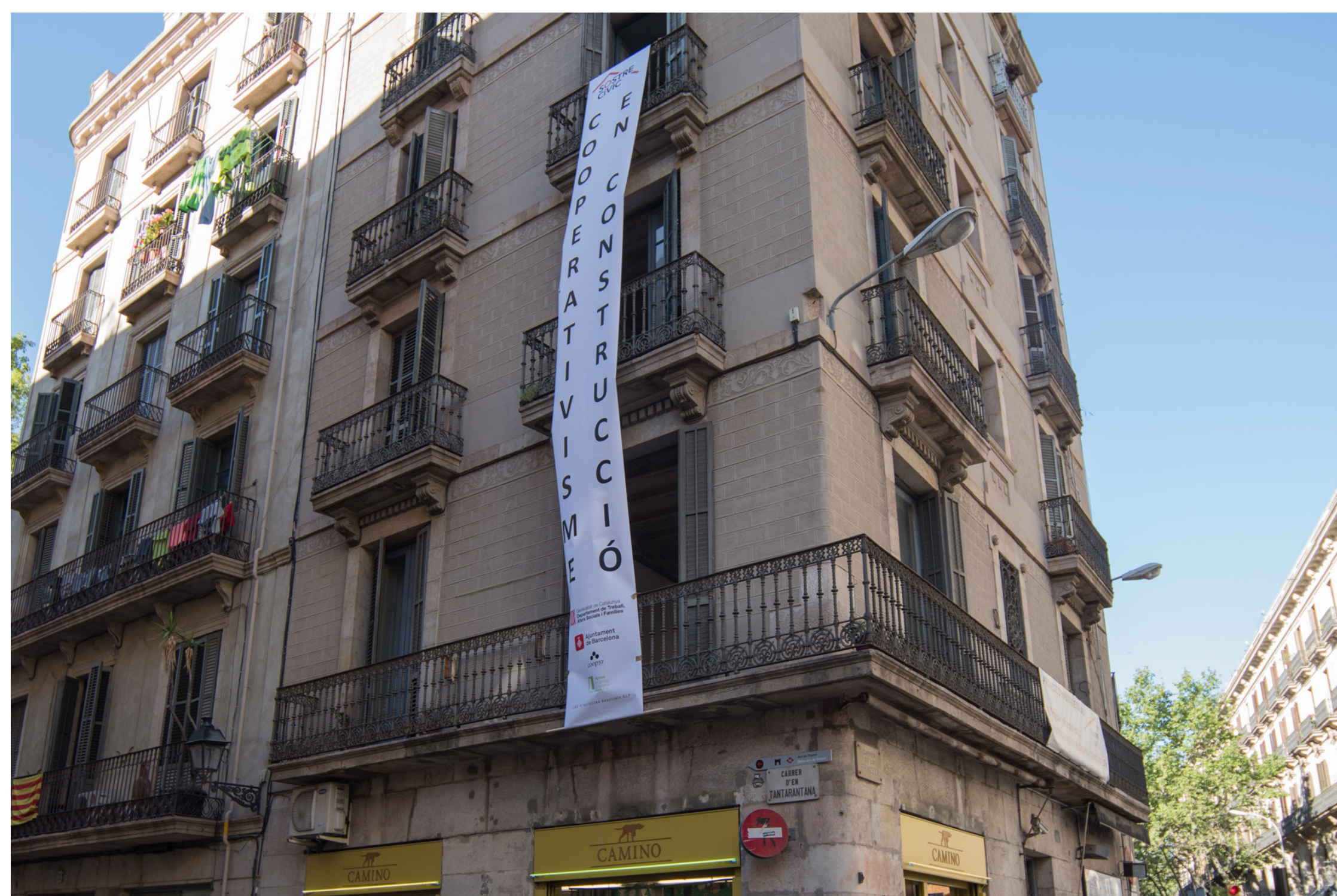
Acte d'inici de les obres de rehabilitació
