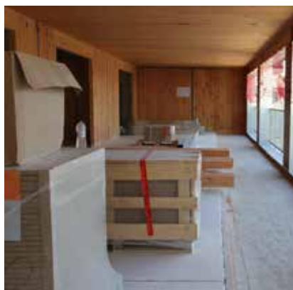
Interior de l'edifici de La Balma, en obres
