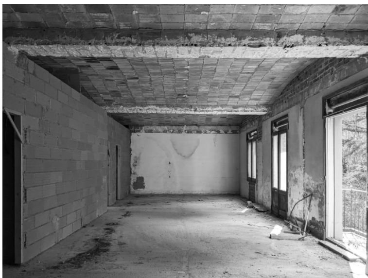
vista interior edifici
