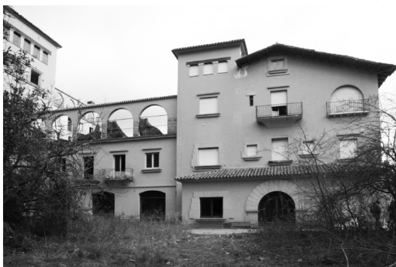
vista exterior des del jardí de la finca
