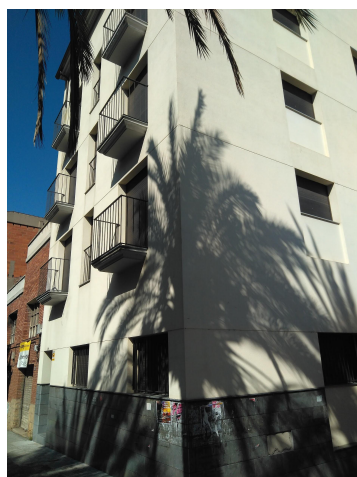
Façana - accés carrer Mur 39
