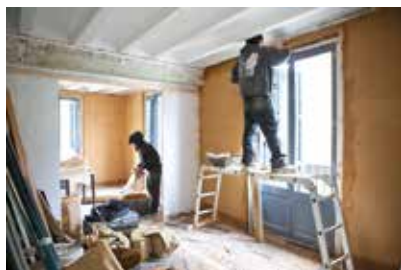
Obres de rehabilitació dels murs de Princesa 49, per Terram
