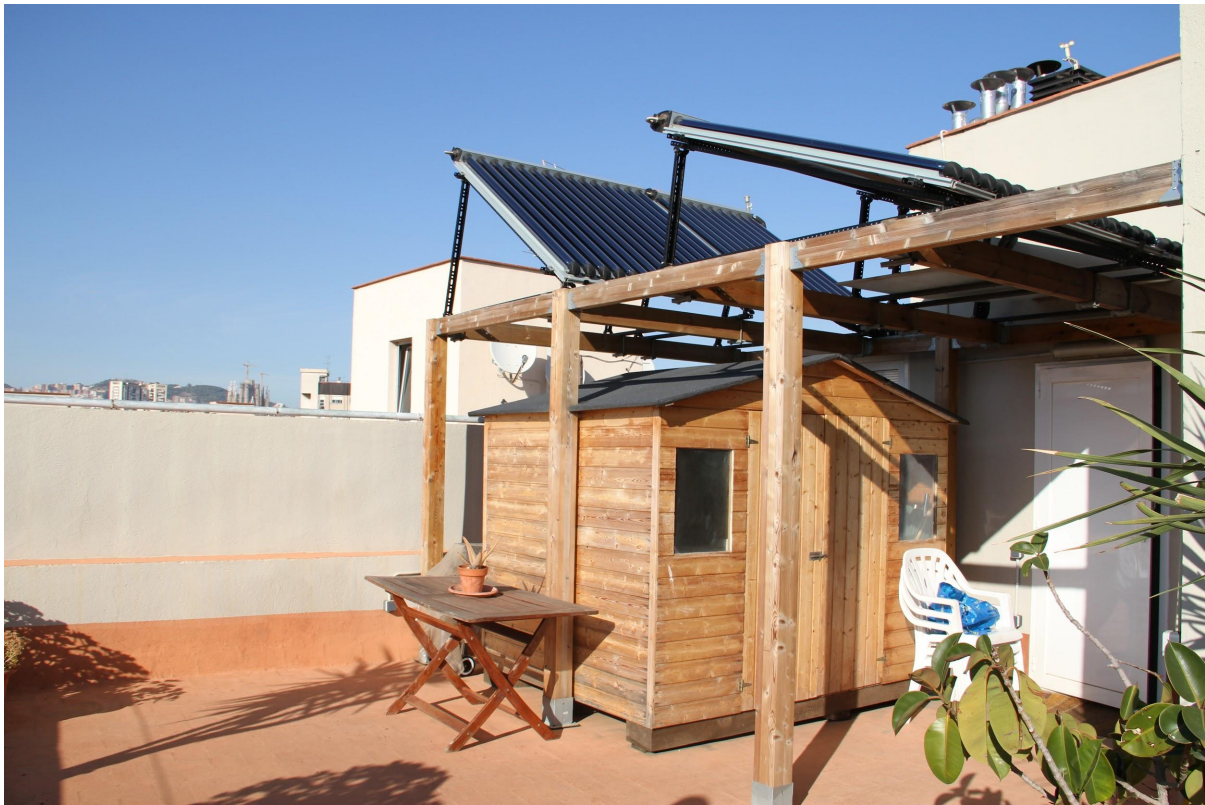
Espais comuns de l'edifici. Terrat.
