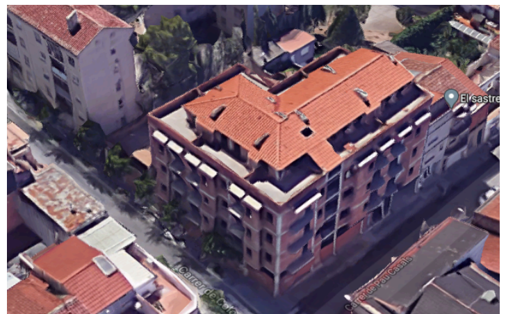
Vista de la finca abans d'iniciar les obres
