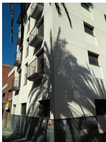
Façana - accés carrer Mur 39
