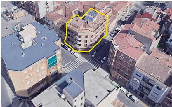
Ubicació de l'edifici al nucli urbà de Lleida
