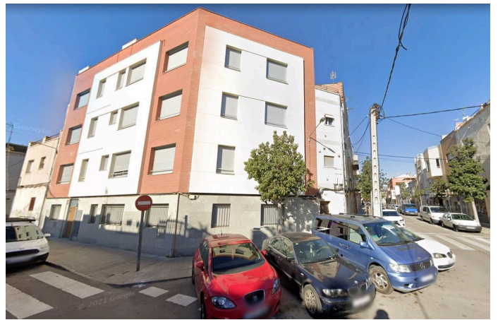
Exterior de l'edifici de La Mola
