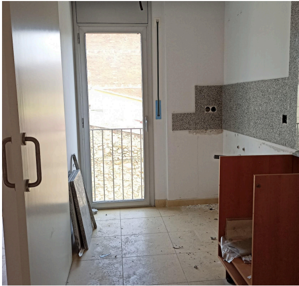
Un dels habitatges abans de la rehabilitació
