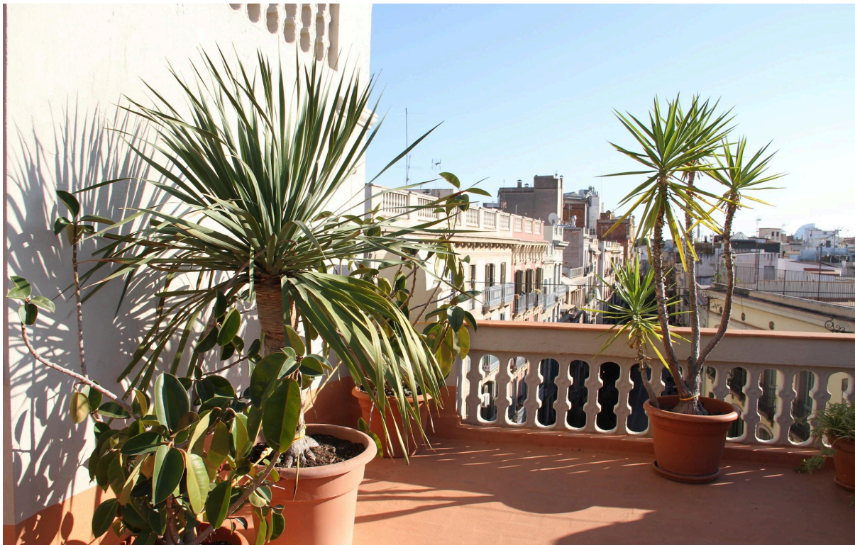
Espais comuns de l'edifici. Terrat
