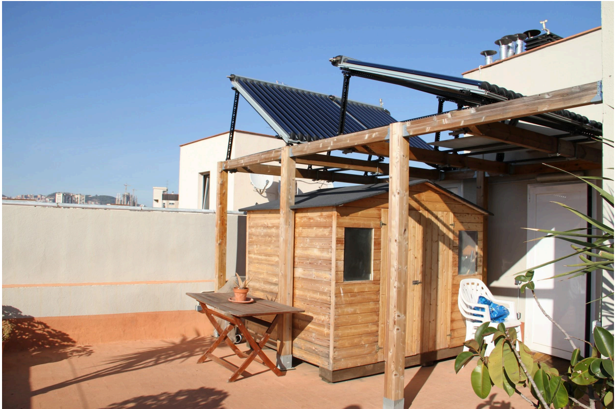
Espais comuns de l'edifici. Terrat.
